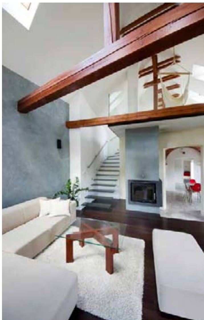
Obývací pokoj je otevřen až na galerii v podkrovní. Vedou na ní schody ze silnostěnného ocelového plechu vetknuté do obvodové zdi. Křbové těleso a západní stěnu zdobí cementová stěrka
