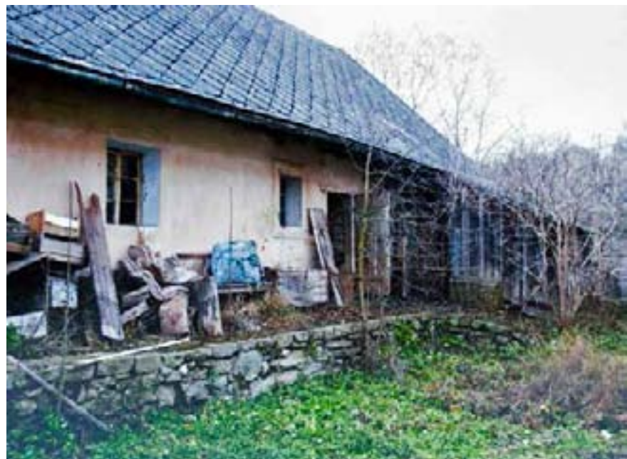
Dřevěný přístavek, další typický znak venkovských stavení, po rekonstrukci zmizel. Zvýšené zápraží se rozšířilo v terasu s dřevěnou palubou
