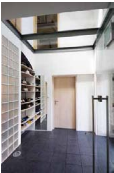
Nová předsíň vznikla tam, kde byly původně schody na půdu. Strop tvoří silnostěnné sklo osazené do rámu z ocelových profilů. Dennímu světlu otvírají cestu také skleněné dveře a příčka z matných skleněných tvárníc (za ní je koupelna)
