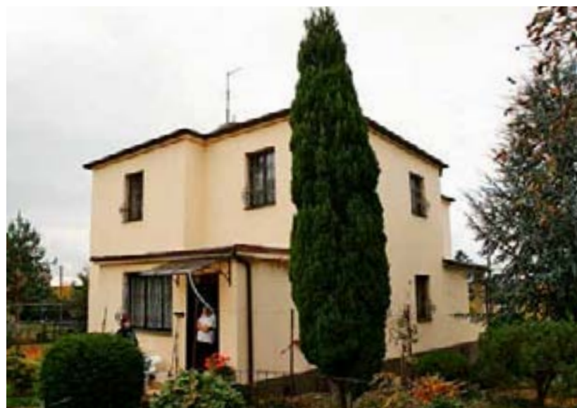
Stav před rekonstrukcí. Dům byl mnohem menší, nečitelného tvaru, kované mříže a další prvky neodpovídaly stylu architektury
