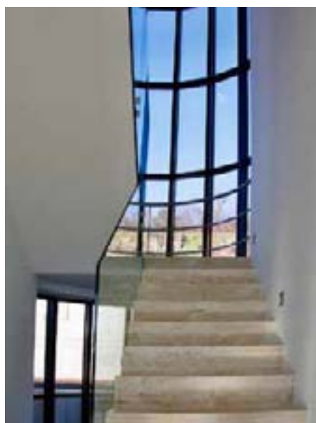
Schodiště je obloženo travertinem a osvětleno prosklenou stěnou přes celou výšku domu
