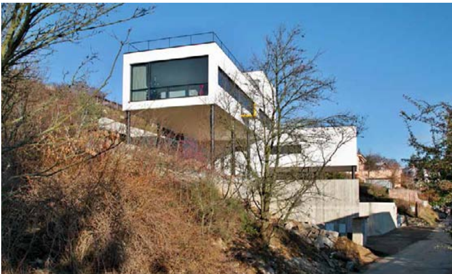
Pohled na severní stranu domu. Z hlavní hmoty vystupuje prosklené schodiškové těleso, další okna sem nevedou. Obývací pokoj bude v budoucnu propojen se zahradou za domem venkovním schodištěm
